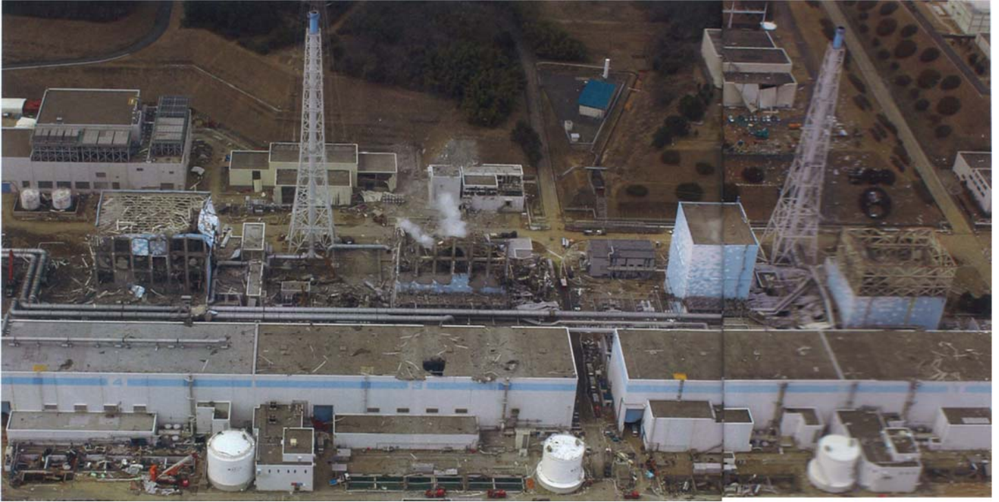
福島第1原発(左から4号機→1号機)エネルギーフォーラム5月号より 21
