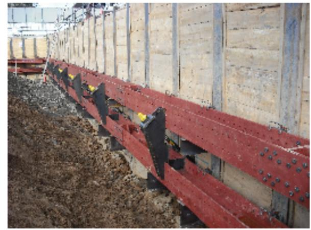
ワイヤー（PC鋼線）を緊張させ土留壁を抑え込みます。
