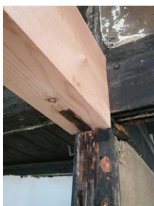
梁を新しく入れ替えます
