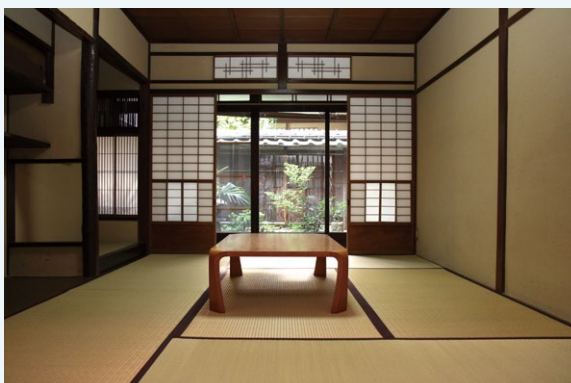
居間は壁を塗り直して、畳を入れ替えたのみ。 小窓がついた障子は改修前のものを使用。
