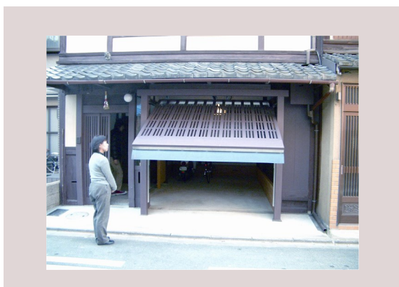
改修後（ガレージ開時）
