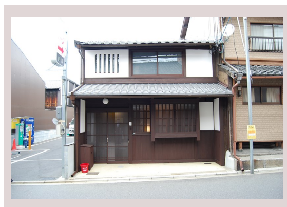
改修後（正面より）
