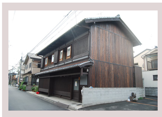
改修後（別アングル）
