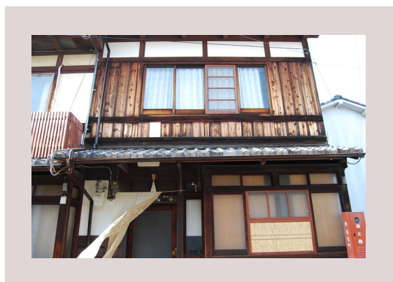
改修後（別アングル）
