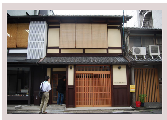
改修後（一軒正面より）
