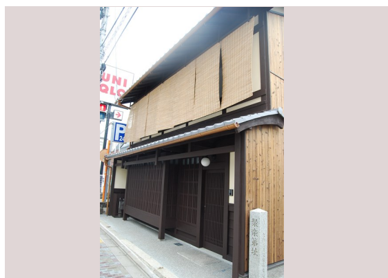
改修後（別アングル）
