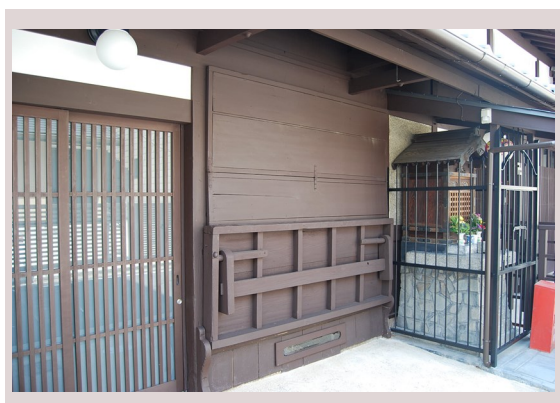
改修後（玄関周辺）
