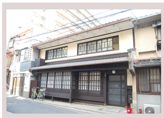
改修後（別アングル）
