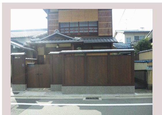
改修後（塀部分）
