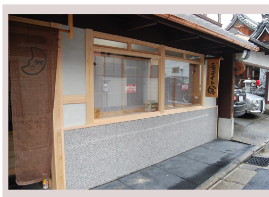
改修後(一階外観)
