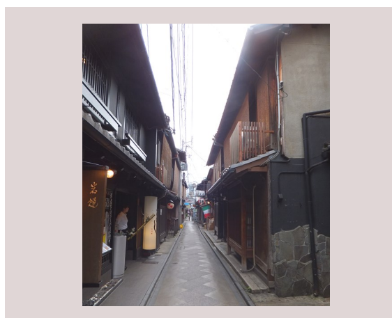
改修後(通りの様子)
