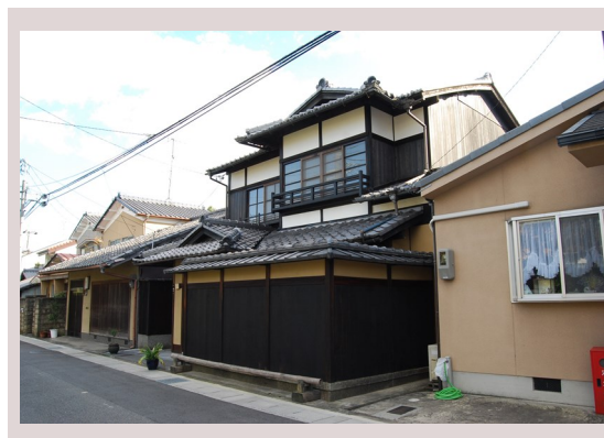
改修後（周辺の様子）
