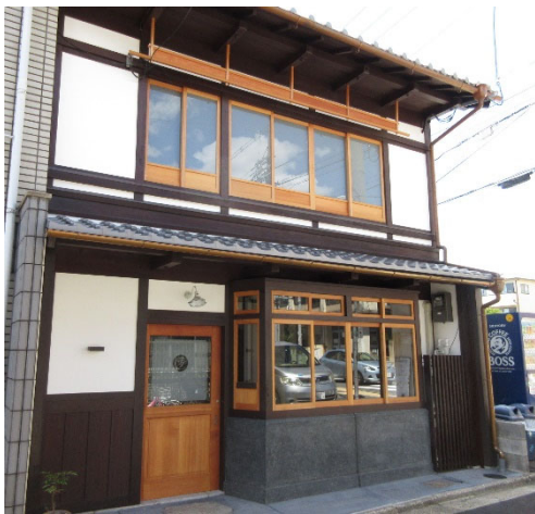
ア：京町家の改修
