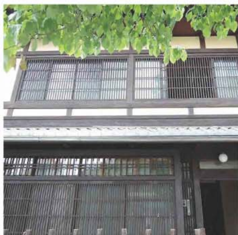
改修工事中の町家 2017年7月撮影
