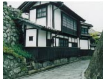
自然条件や建築は大きく改変せず、手入れを重ねながら次代に継承しているのがうかがえます
