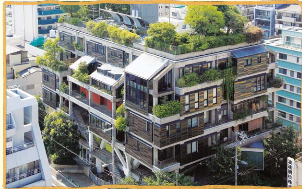
実験集合住宅NEXT21 写真提供：大阪ガス(株)
