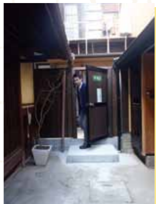
緊急避難扉の設置
