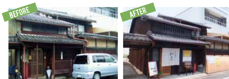
改修前の喜多見家
