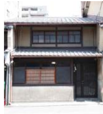
図2-5-2 釜座町町家修復前
