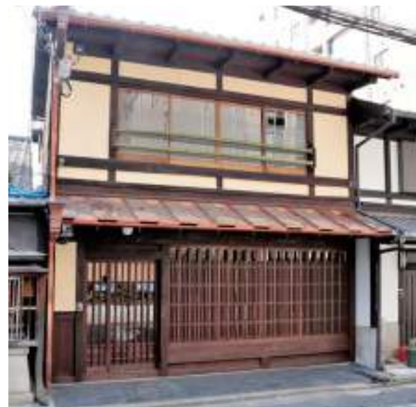
図2-5-7 四条町大船鉾会所(改修後)
