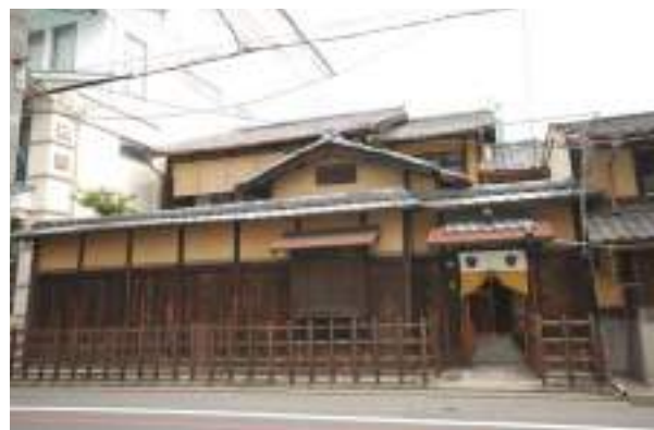
図2-5-5 旧村西家住宅外観
