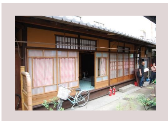
改修後（敷地奥側）
