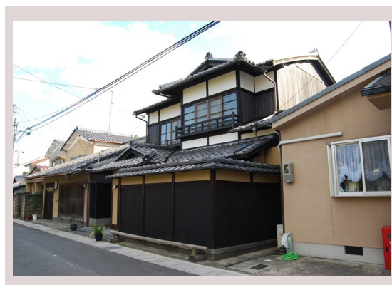
改修後（周辺の様子）
