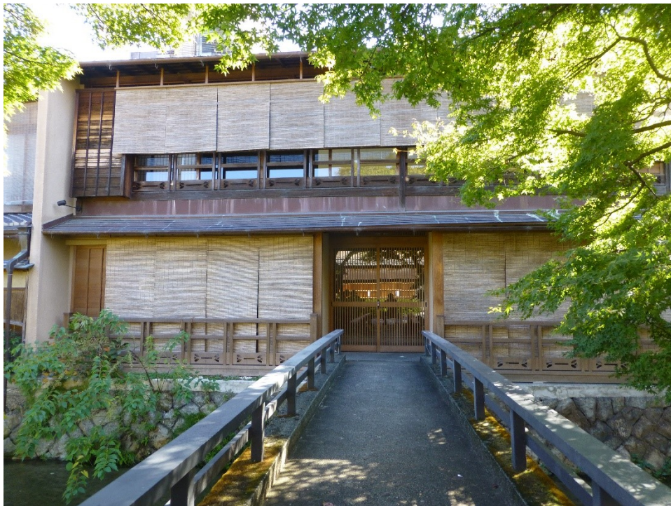
祇園新橋歴史的建造物 外観写真
