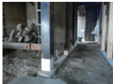
(写真2) 柱の足元が根継ぎされている(白い部分)様子
