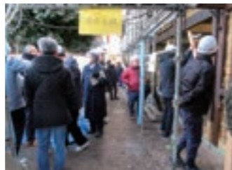
改修が進められている路地
