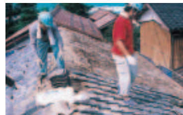
住民とボランティアが一緒になって解体作業を行いました
