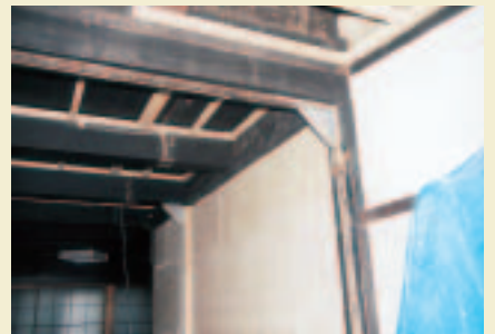
仕口ダンパーと荒壁パネル
