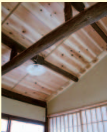
梁の見える天井に改修されました。
