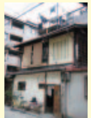
東山安井の町家 (改修後)
