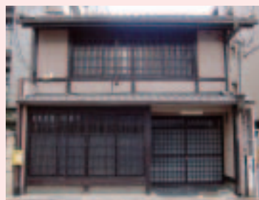
以前の大和葺(板庇)に復元することになった船鉾町会所
