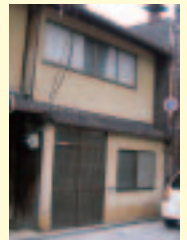
宮川町の町家 (改修前)
