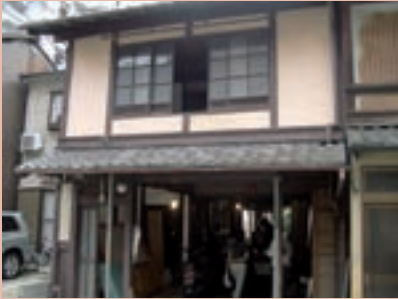
現代の生活にかなった京町家として改修中の池内邸
