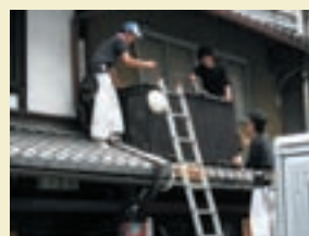
室外機カバー設置の様子
