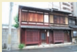
現在右側の町家を改修中のアリサハウスミュージアム
