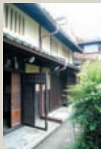
出水町家外観
