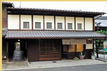
ギャラリー be 京都 外観 平成18年度に京町家まちづくりファンドを活用して改修されました。
