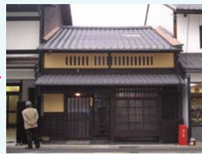
改修後 屋根に注目！
