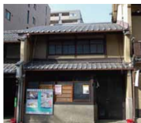
修復予定の釜座町の町家
