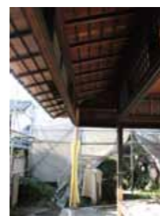
座敷部分の庇(施工中)
