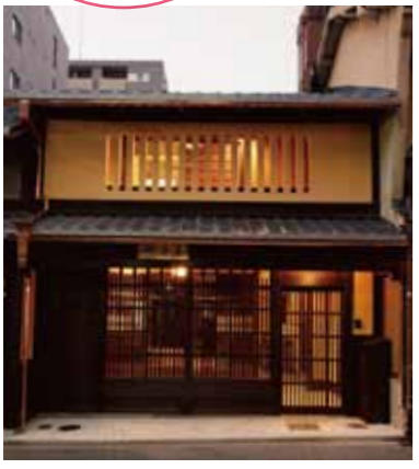
釜座町町家修復完成 (写真：井上成哉)
