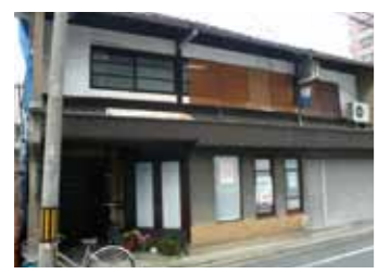
改修前の様子
