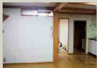
改修前の内部
