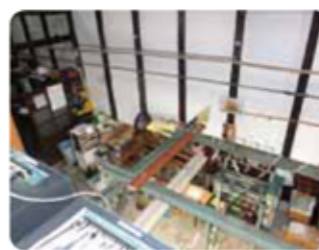
作業場の吹抜け空間
