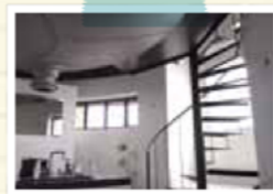
給水塔の内部
