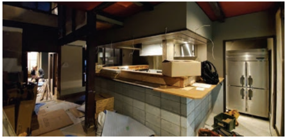
| 改修工事の様子
