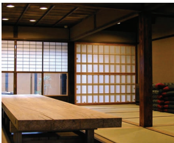
耐震補強された室内
