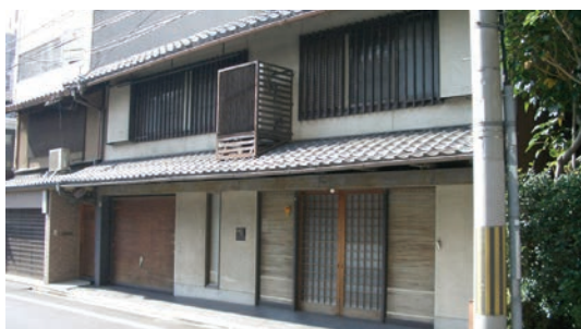
改修前（外観要素を多く残す）
