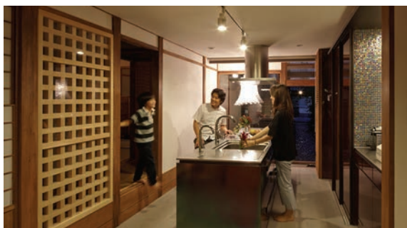
木格子耐力壁による補強
