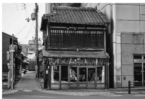
写真 2-4-(1)-5 郭巨山町会所 改修前
