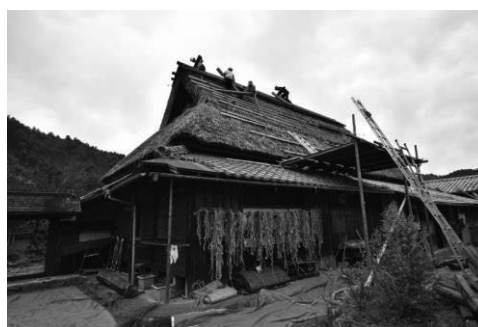
写真 1-5-1,2 茅葺屋根の葺替え修理 : 河原林家
