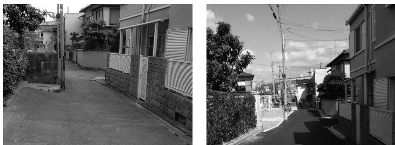
写真 4-1-1 北区紫野西土居町（左 整備前 右 整備後）
