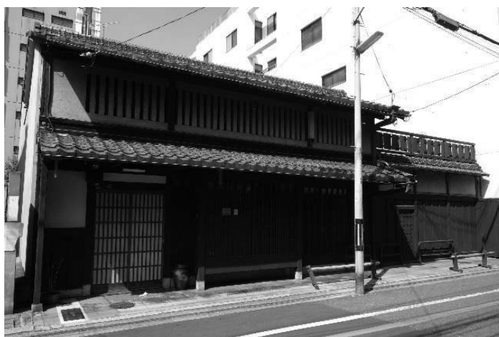
写真 1-1-(4)-1 保全された京町家
