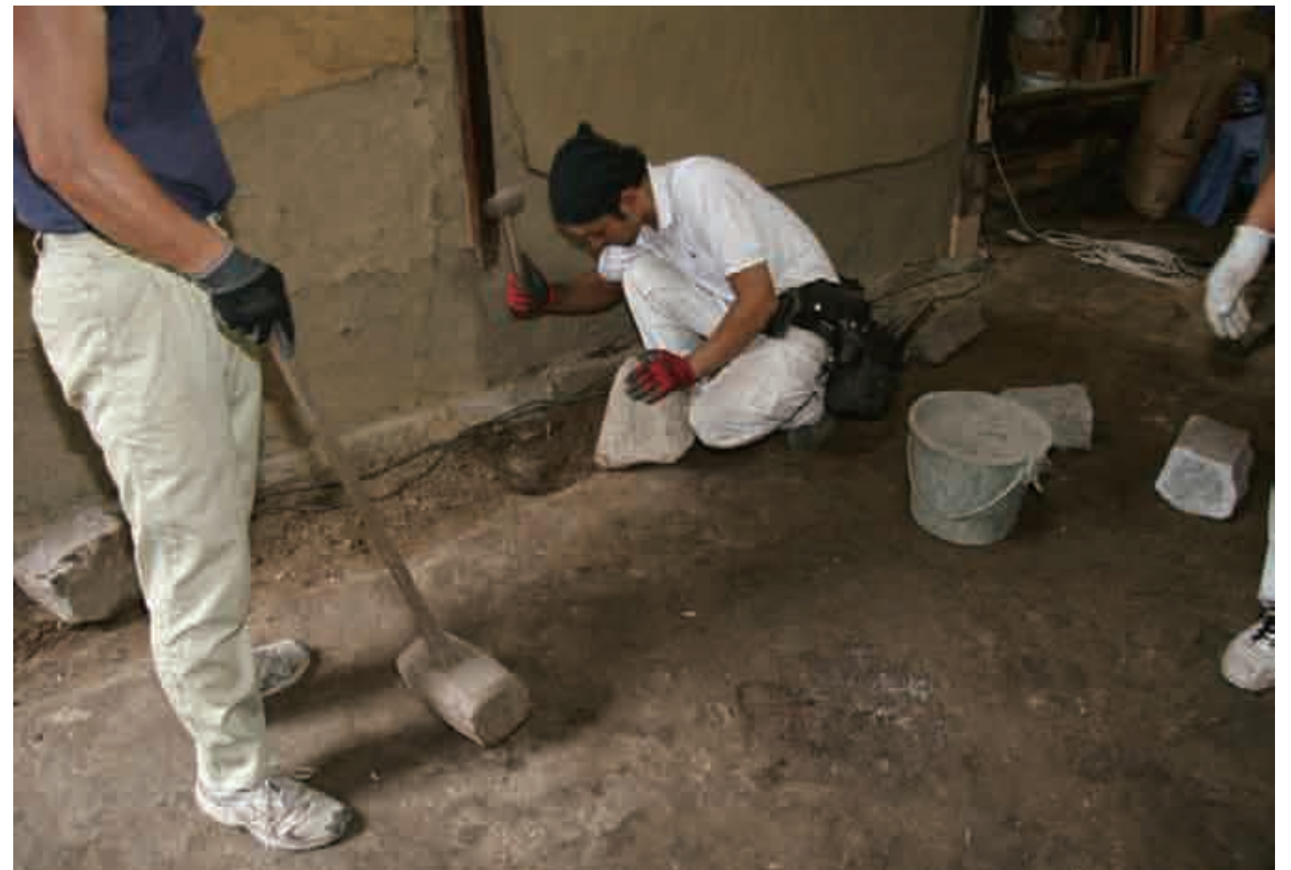
基礎工事 葛石を水平に据え直す leveling foundation stones
