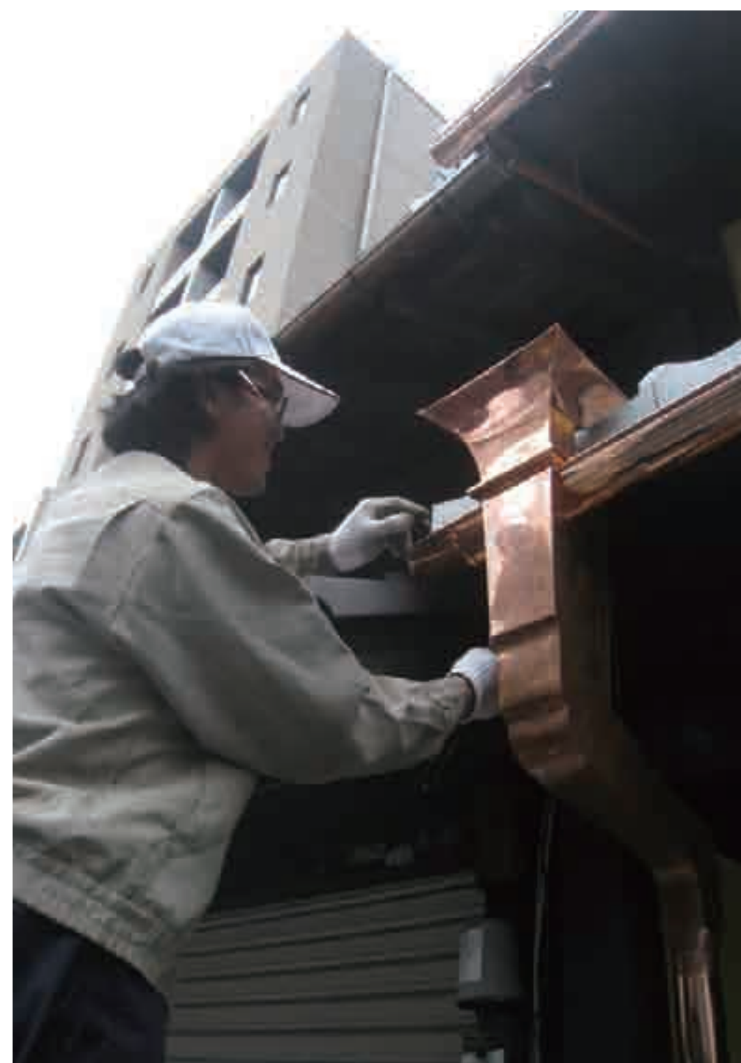
京アンコウの取り付け kyoto-style drain spout
