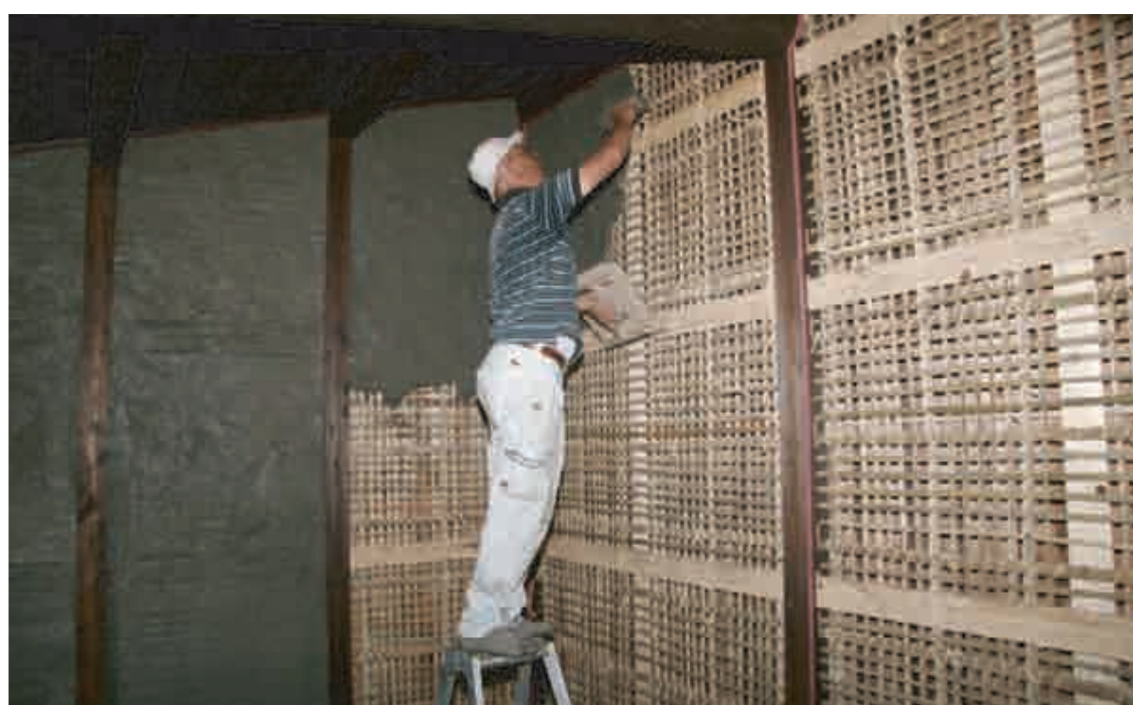
小舞竹に荒土を付ける daubing bamboo wattle
