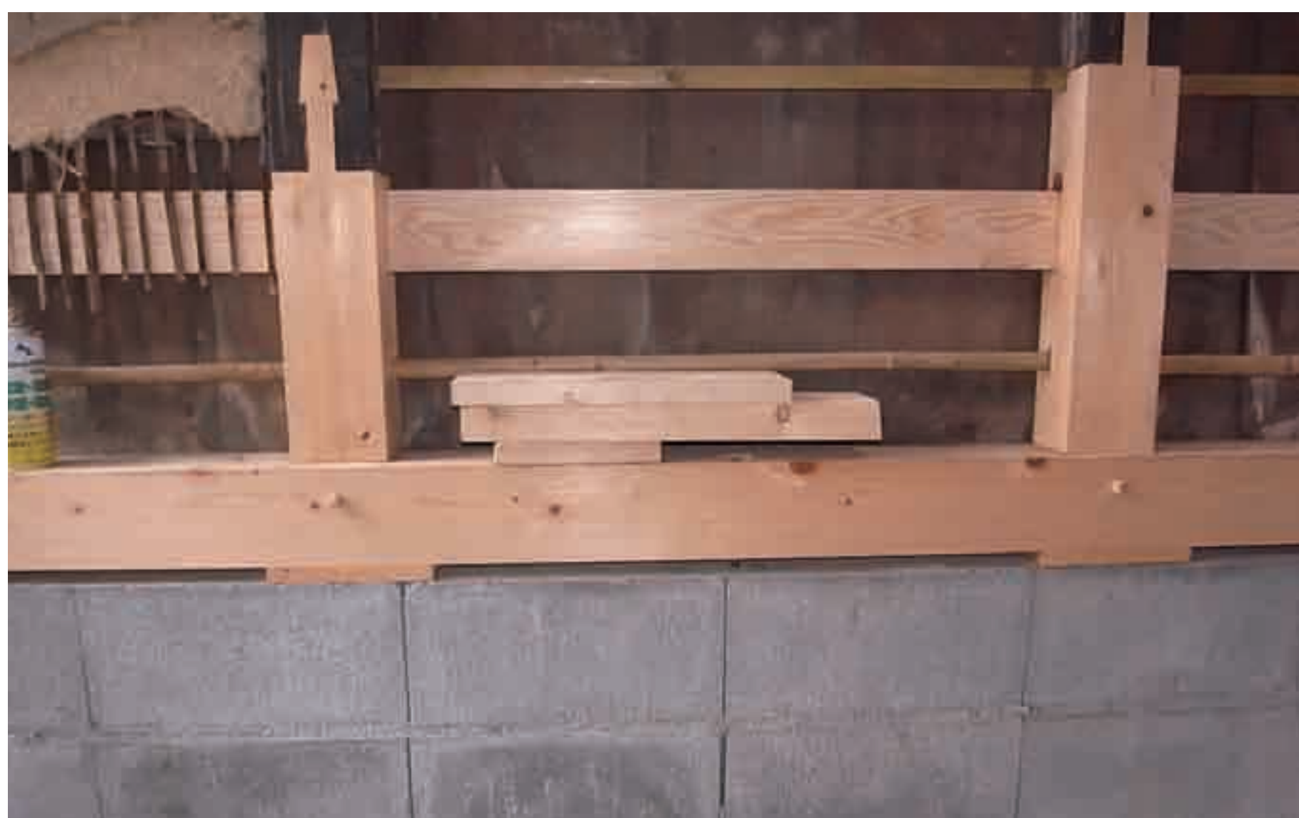
コンクリートブロックの高基礎上に東側柱列を土台と通し貫を新しく入れて載せ直す putting on retrofitted post & beam on new CB foundation
