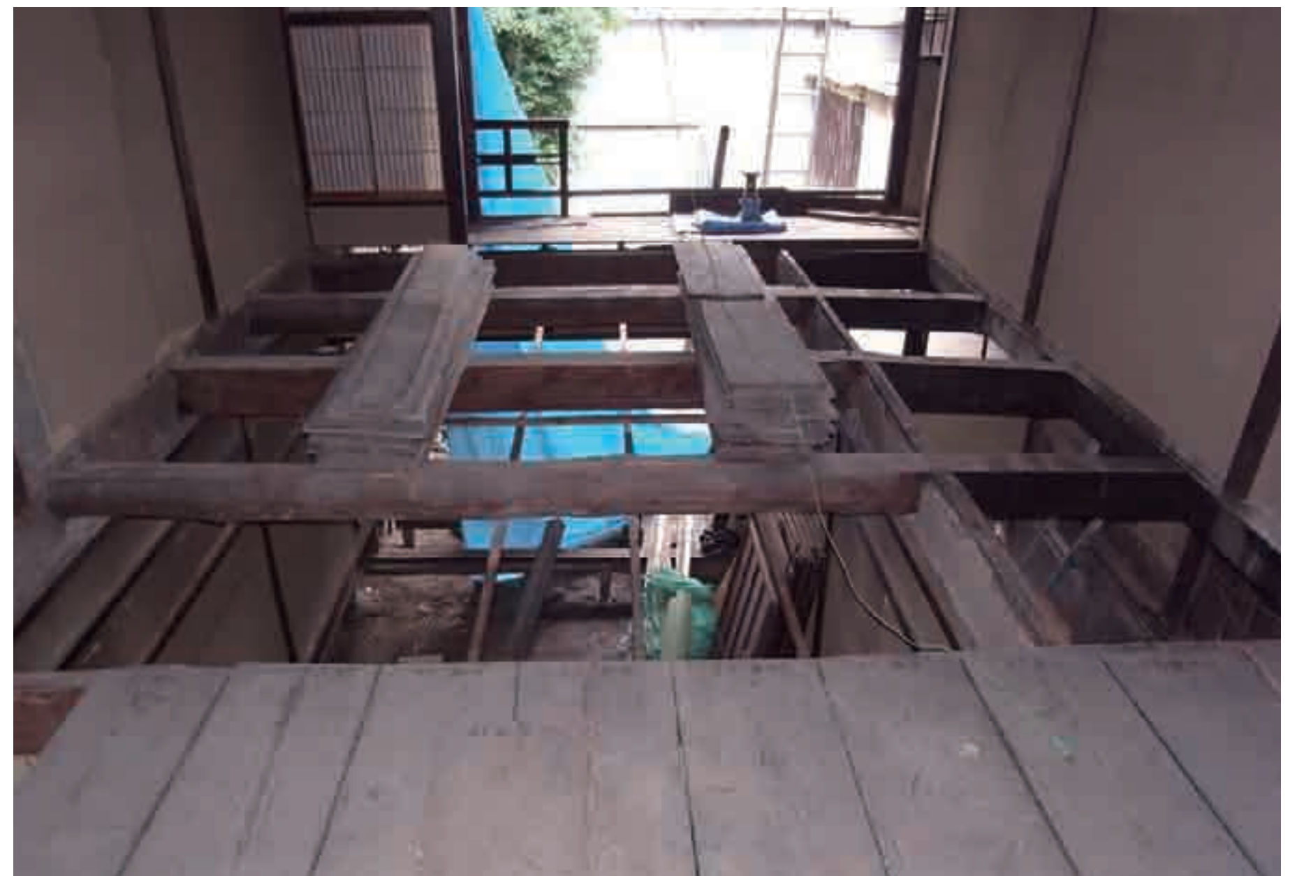
梁の折れ曲がり bent & broken beams
