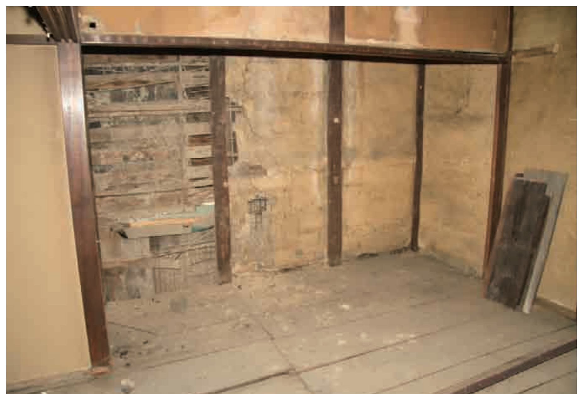
雨水が侵入して壁土が落ちた所 rain-damaged wall
