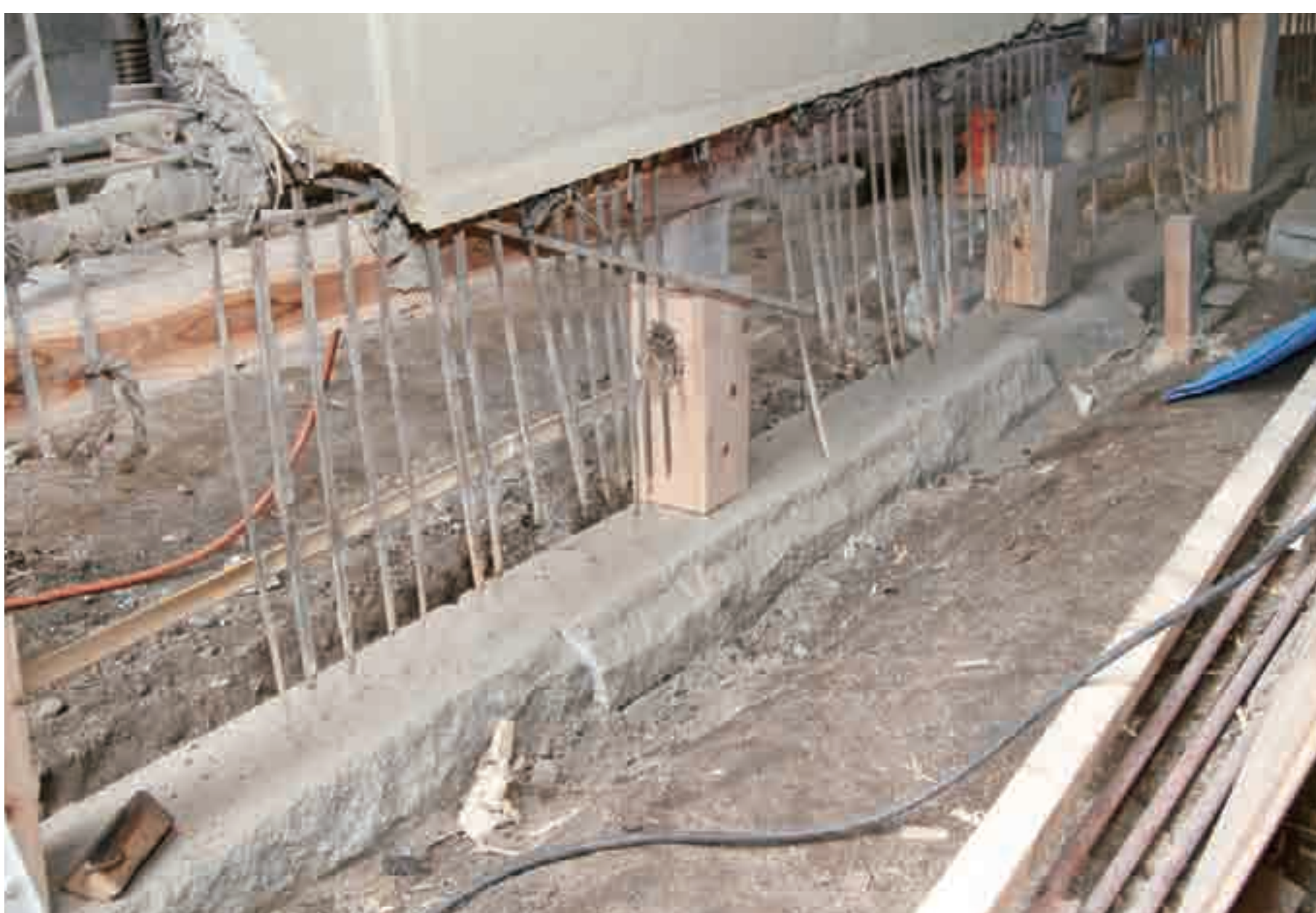
古花崗岩葛石を敷き直し、柱を根継ぎして載せる putting retrofitted posts on long granite stone
