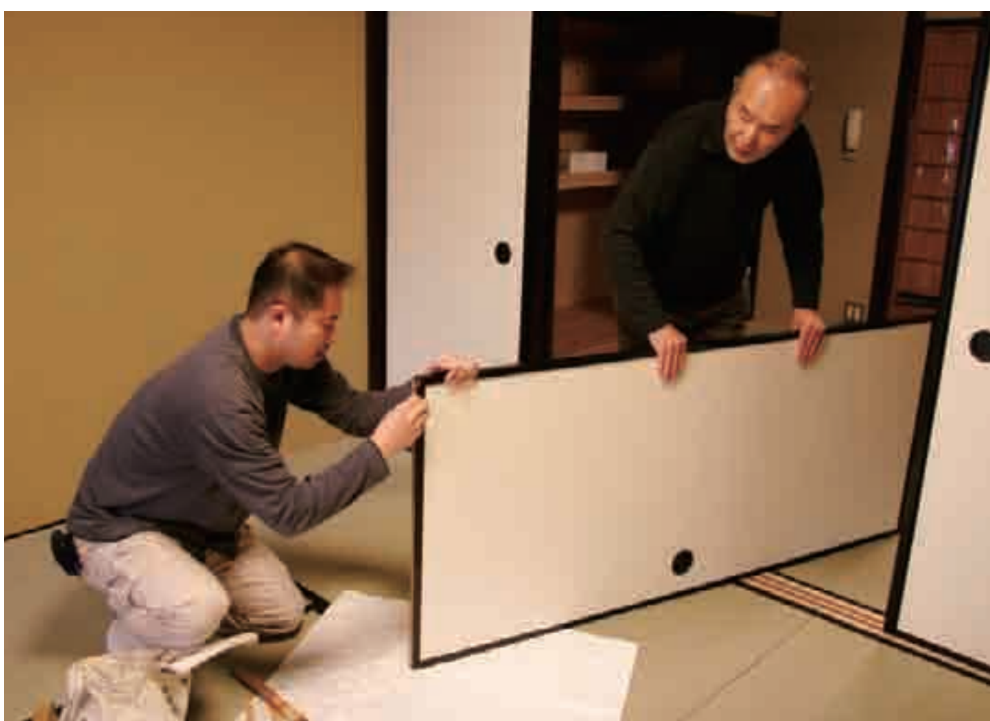
襖を建て合わせる installing fusuma
