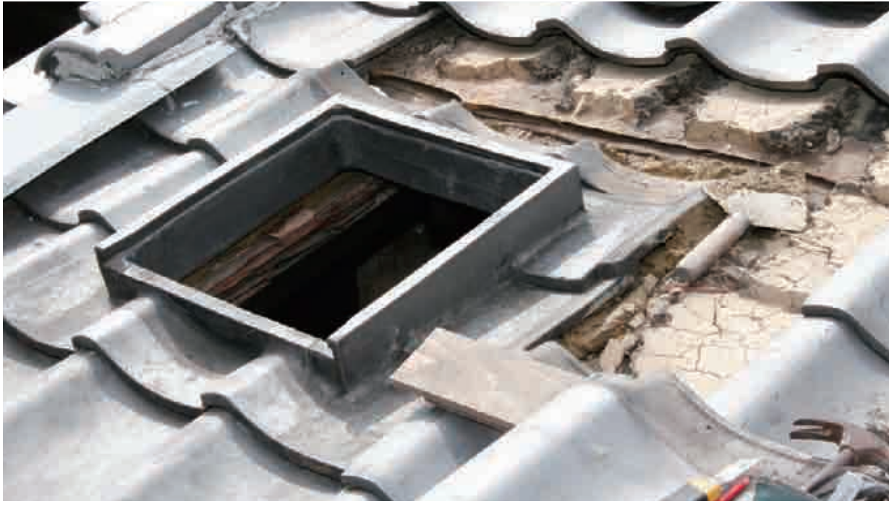
トップライト top light of tile roofing
