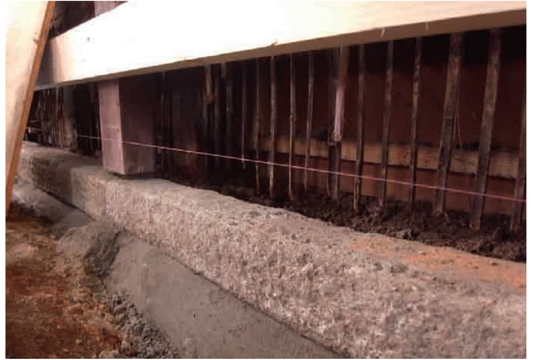
基礎工事 葛石を水平に据え直す leveling foundation stones
