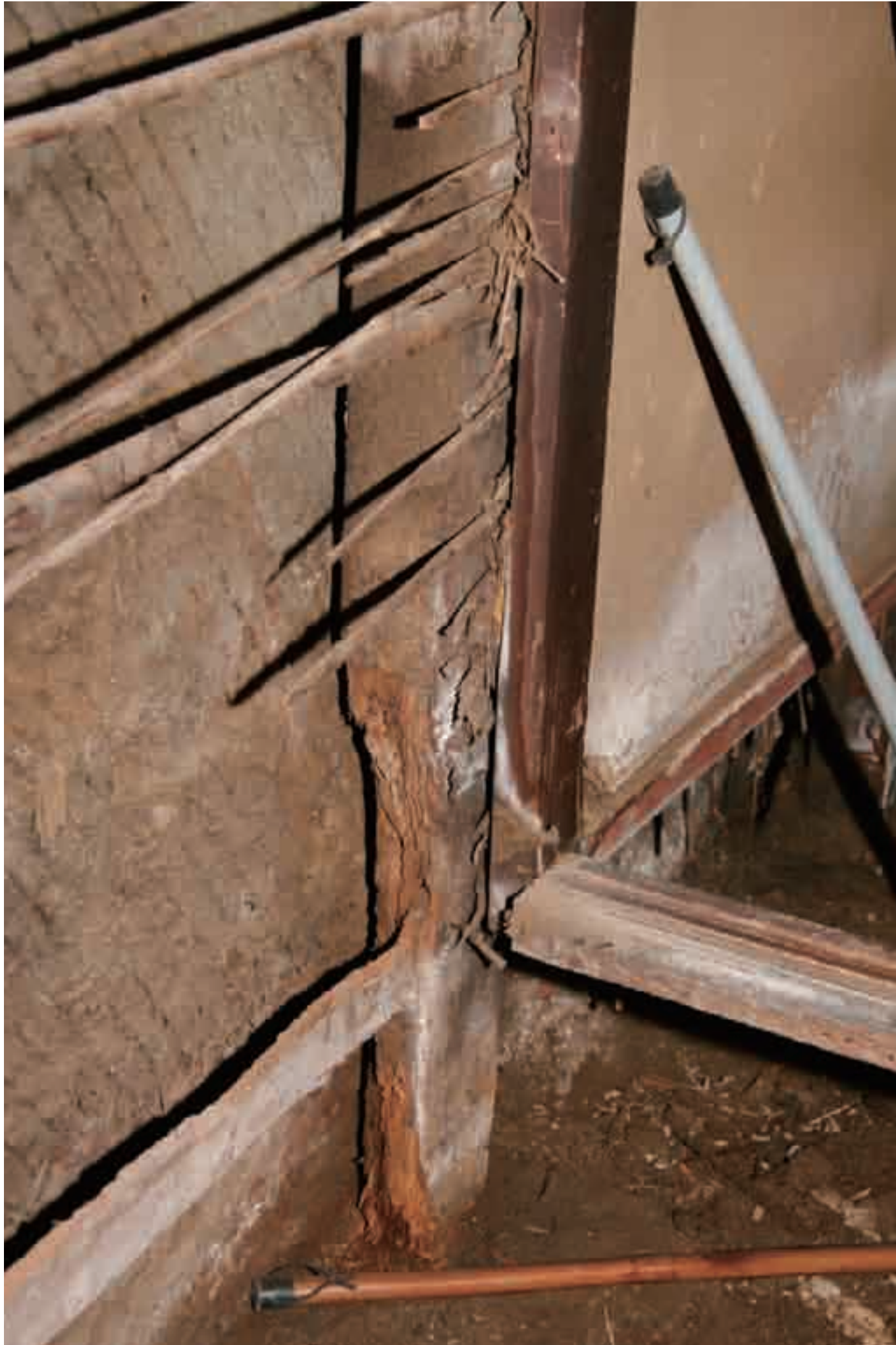
柱の根腐れ rotten post
