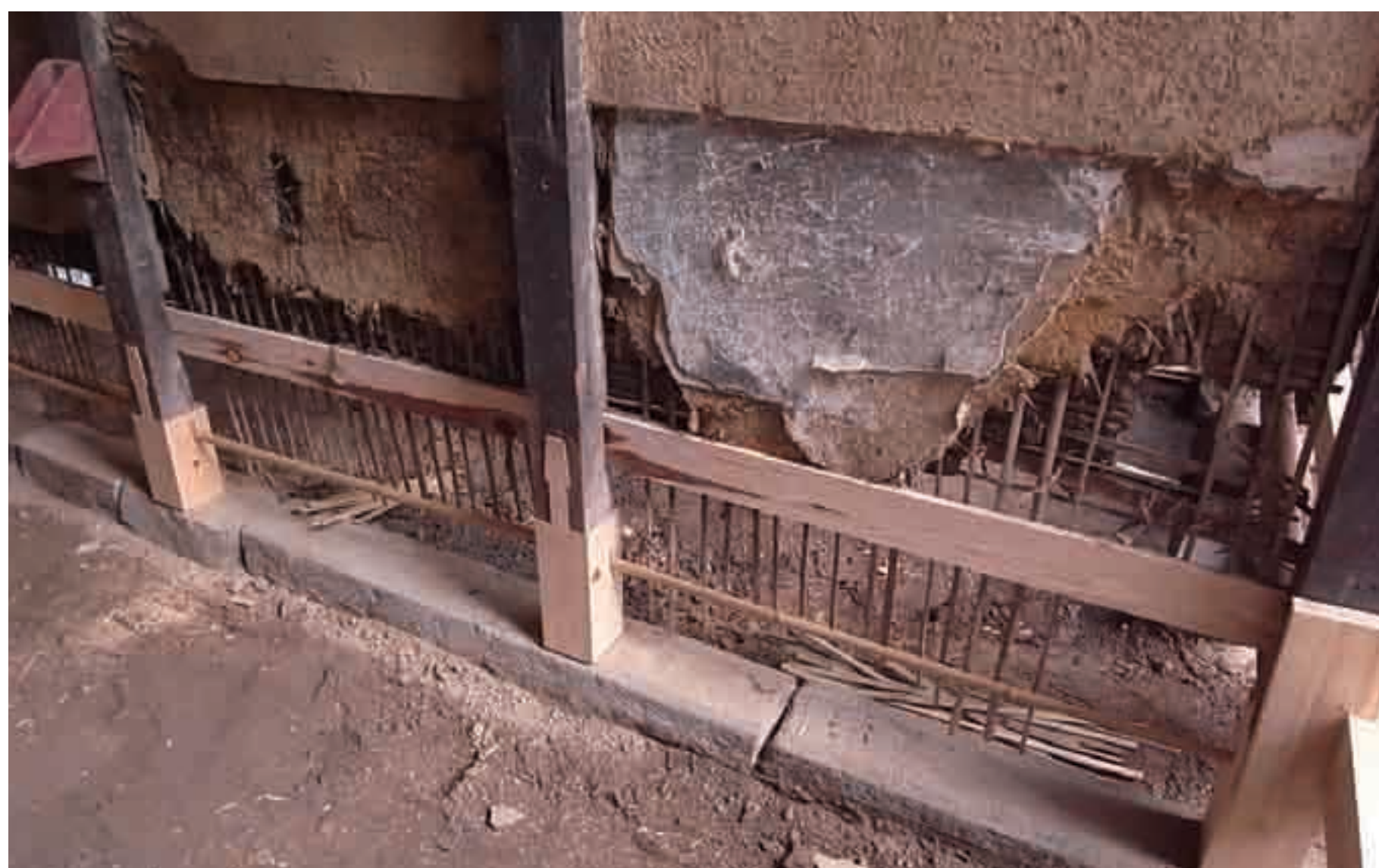
新しく据え直した葛石の上に側柱を根継ぎして載せる（揚前） adjusting posts level
