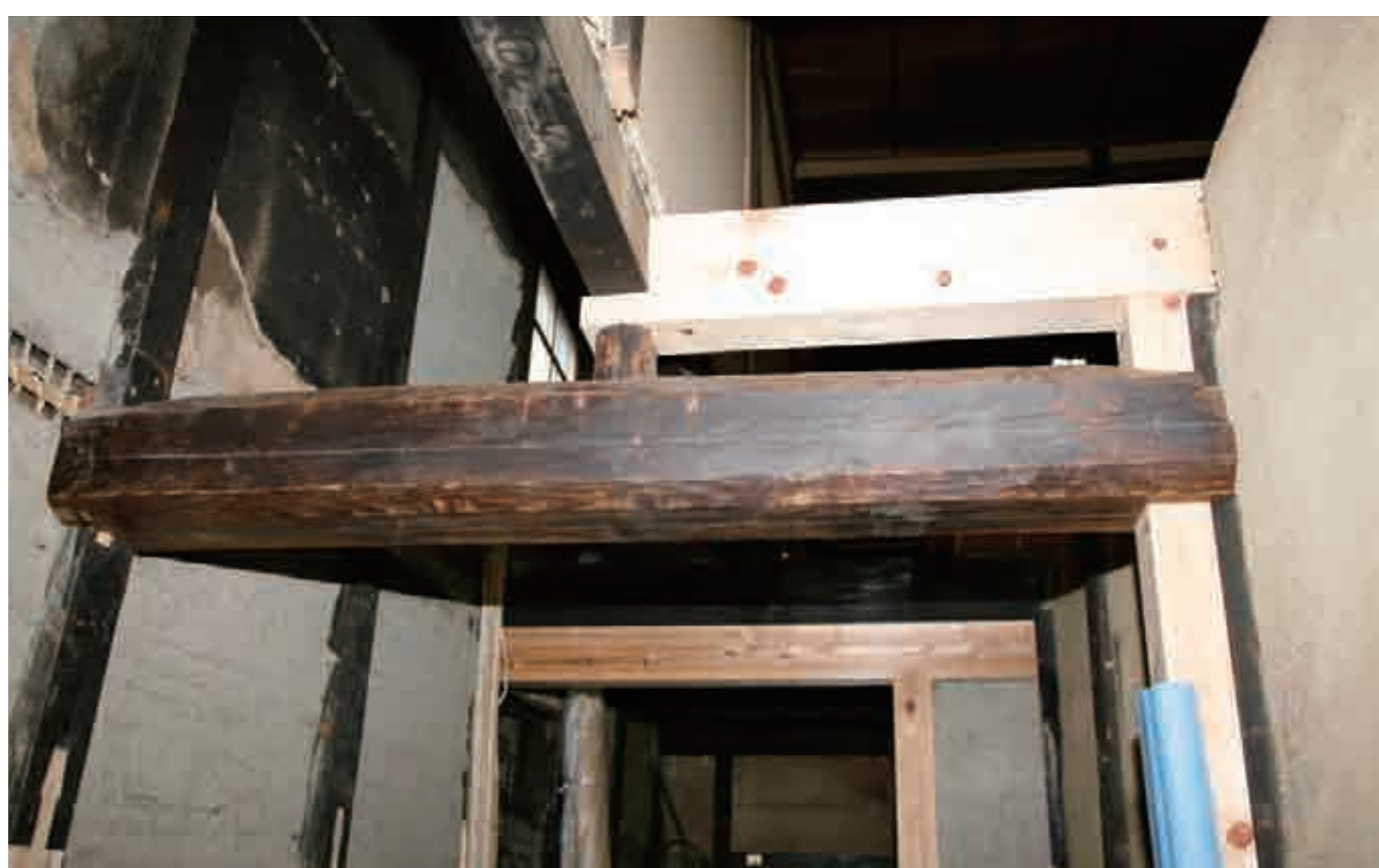
火袋の架構を修理補強 梁と添え柱を入れる retrofitted post & beam
