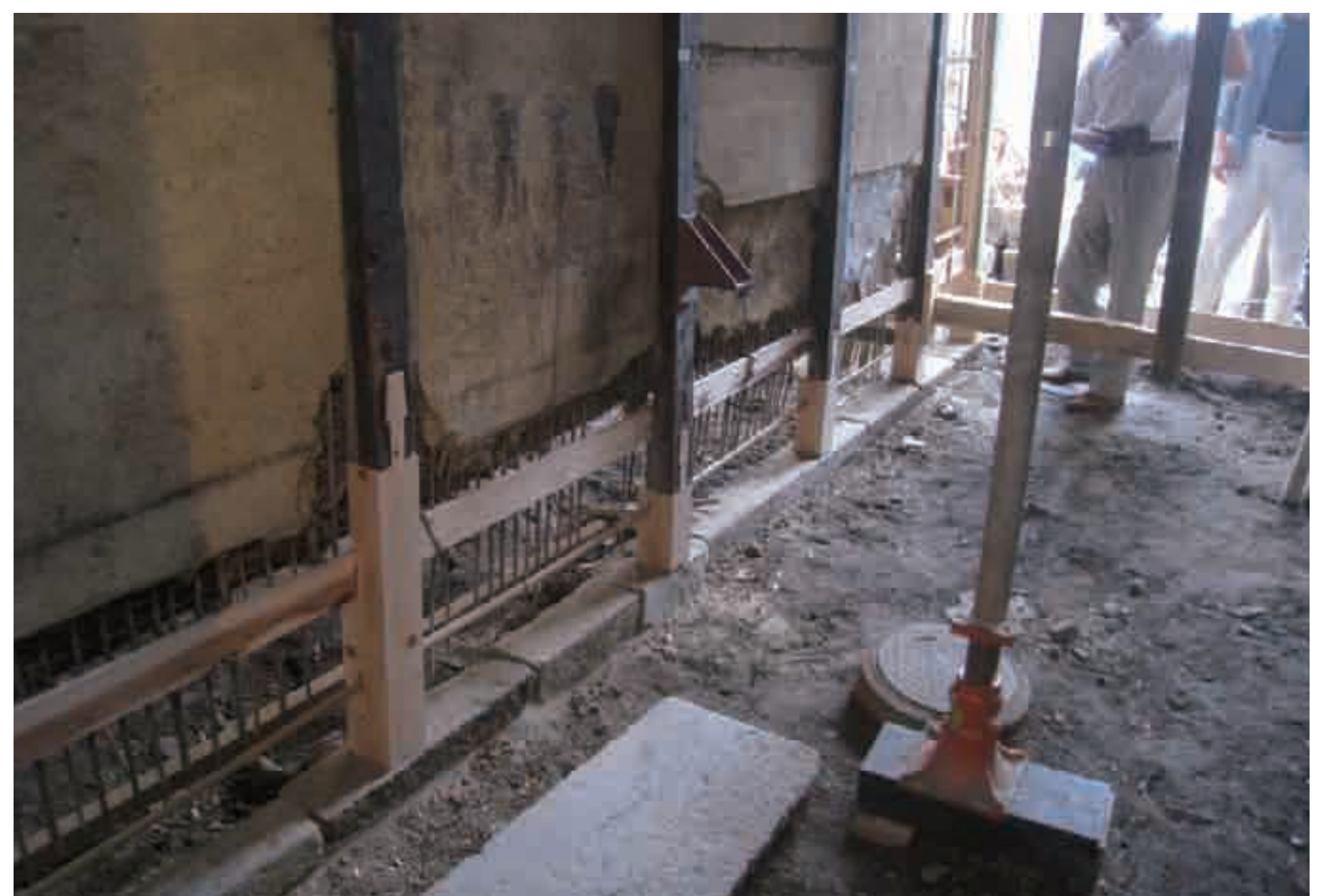
古花崗岩葛石を敷き直し、柱を根継ぎして載せる putting retrofitted posts on long granite stone
