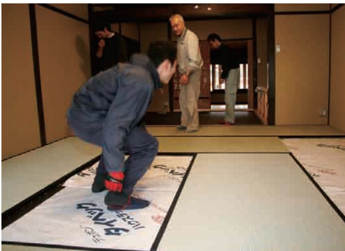
畳敷込み installing tatami
